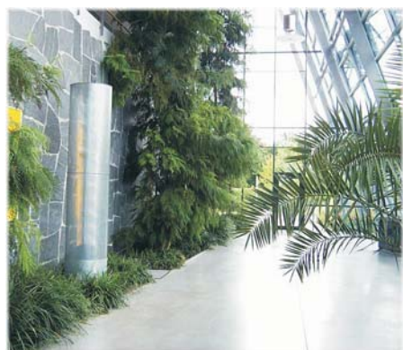
Sortie d'air d'un puits canadien (Solar Fabrik de Freiburg, Allemagne)
